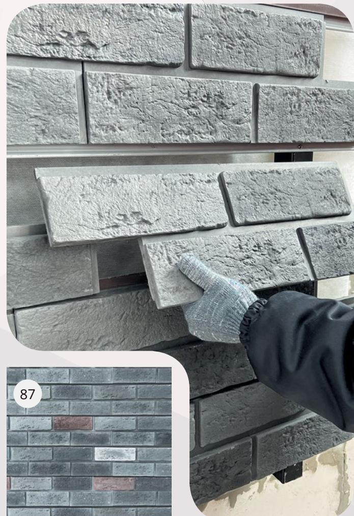
Навесные Фасадные Панели «Гранит» применяются для облицовки задний и сооружений по принципу вентилируемый фасад, их монтаж осуществляется на металлическую подсистему с применение крепёжной планки ПФК
